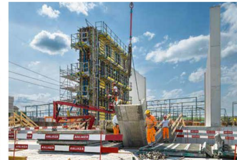
Schalung der Trafowände
