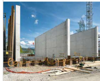
Trafowände 12 Meter hoch
