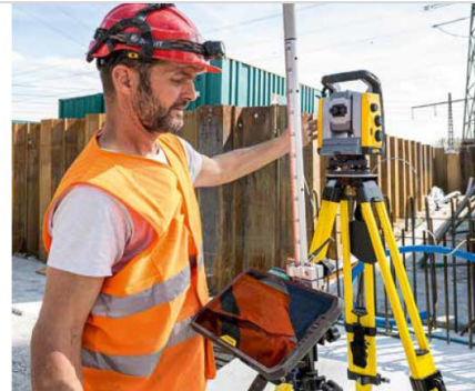
Absteckung mit Robotic Total Station von Trimble
